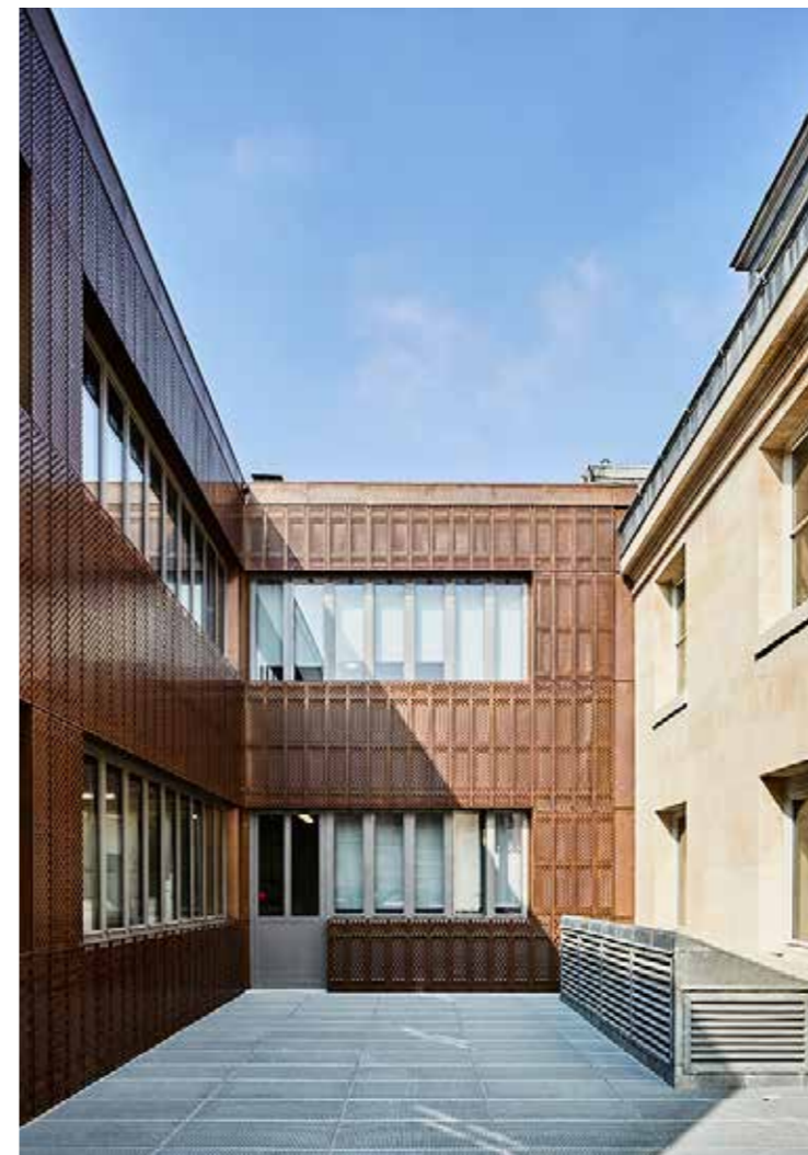
En haut : vue sur le passage de la Gravure Ci-contre : le nouvel atelier en cuivre et les facades en pierre
