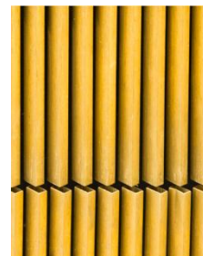
Dettaglio di facciata: la griglia dei profili in ottone © João Morgado
