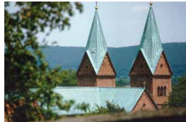
6. kép A kolostor felújított teteje
