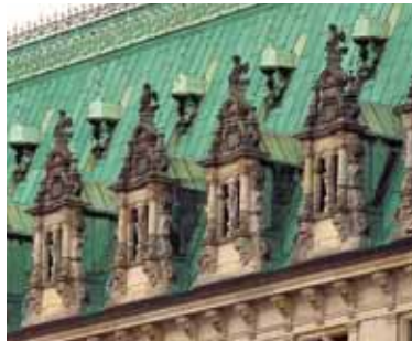
4. kép A régi rézelemek és az új előpatinázott rézlemez közötti színbeli különbségek lassan kiegyenlítődnek.
