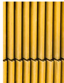
Detalle de la fachada: red de perfiles de latón © João Morgado
